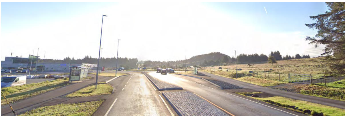
Figur 5-31: Eksisterende krysningspunkt ved Veakrossen, Gående og syklende må vike for bilister.
