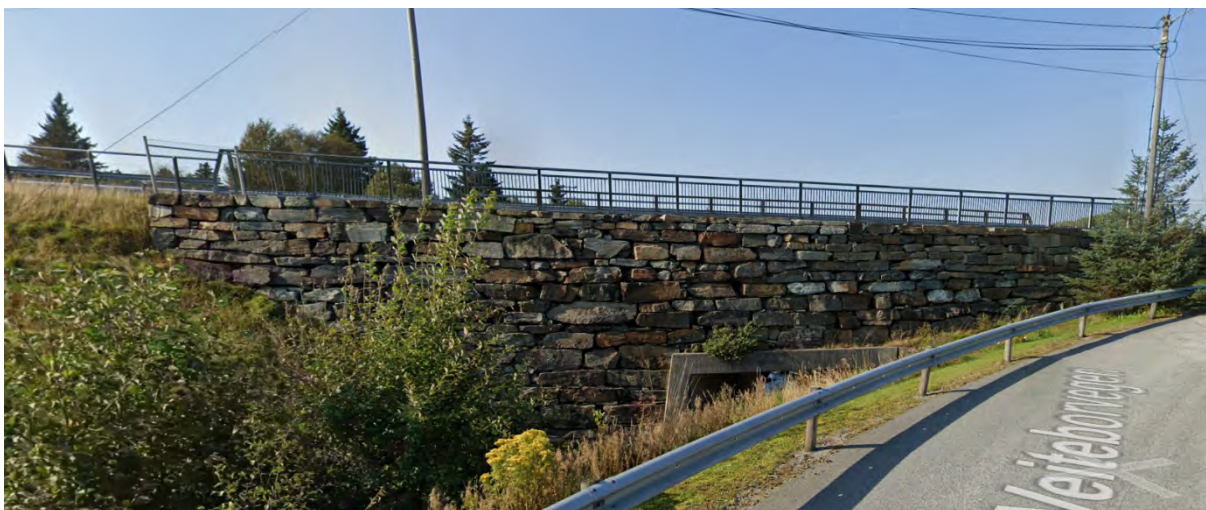
Figur 5-36: Eksisterende bru ved Brekke er gammel og har begrenset levetid.
