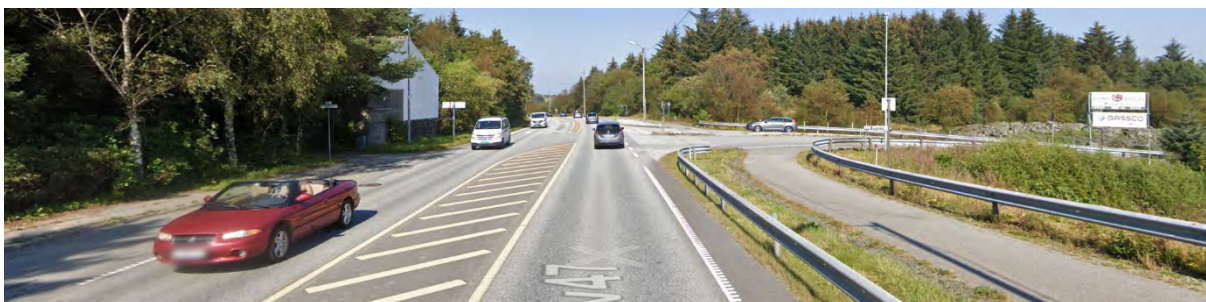
Figur 5-73: Eksisterende T-kryss ved Gassco
