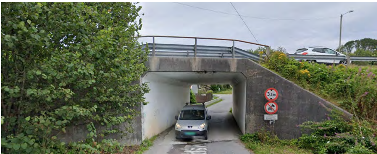
Figur 5-52: Eksisterende undergang under fylkesvegen ved Øygardsvegen.
