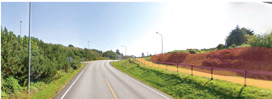
Figur 5-78: Krysningspunktet ved Hydrokrysset sett fra sykkel- og gangvegen under bru. Situasjonen er uoversiktlig, og bilister kan være lite synlig for syklister i høy fart.
