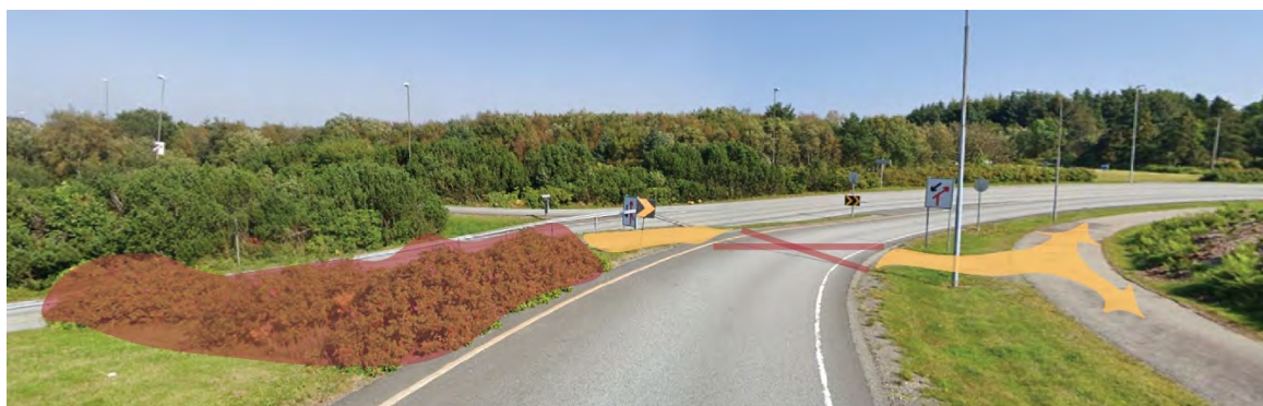
Figur 5-77: Krysningspunktet ved Hydrokrysset sett fra avkjørselsrampen på Hydrokrysset. Situasjonen er uoversiktlig, og syklister kan være lite synlig for bilister i høy fart.
