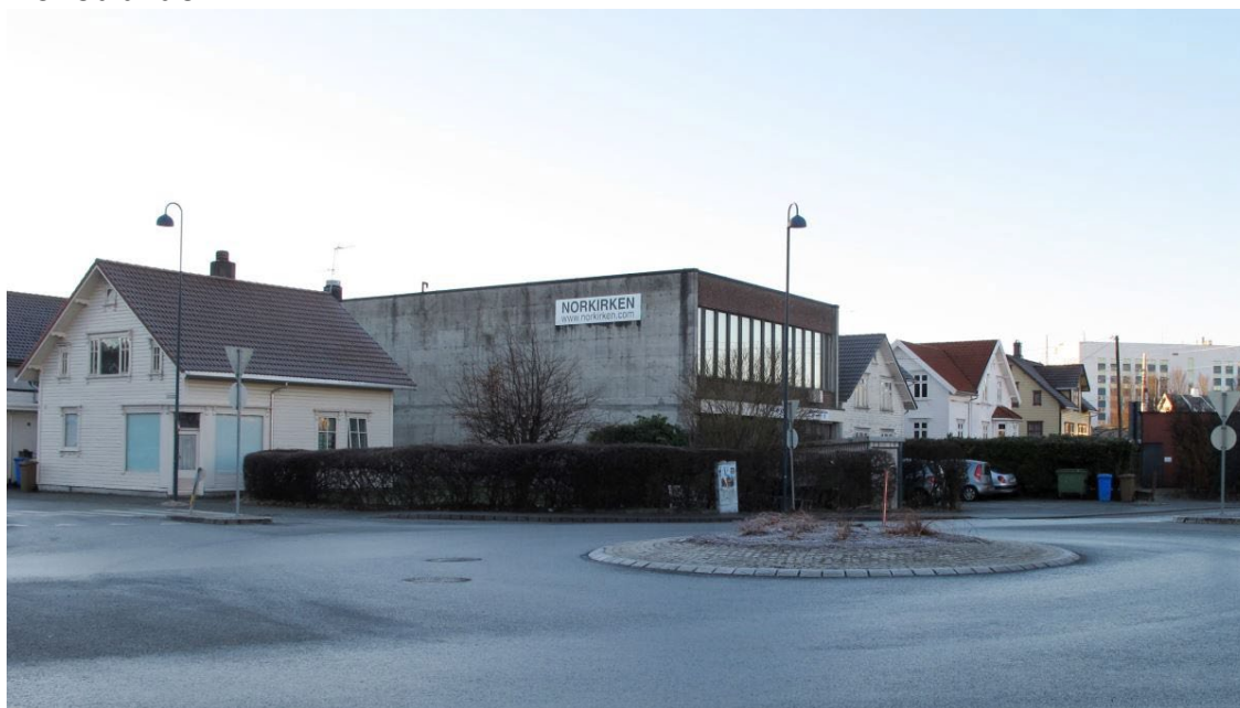
Bygningsmiljøet rundt Norkirken lengst nord i Gamle Vågsgjerd Bilde hentet fra Sandnes kommunes kulturminneregister, 06.12.2016 10:35
