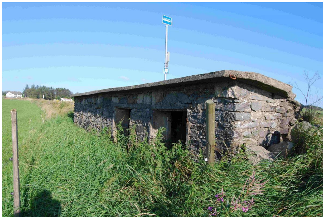
Støttepunkt Heigre - bunker ved kontrollpost
