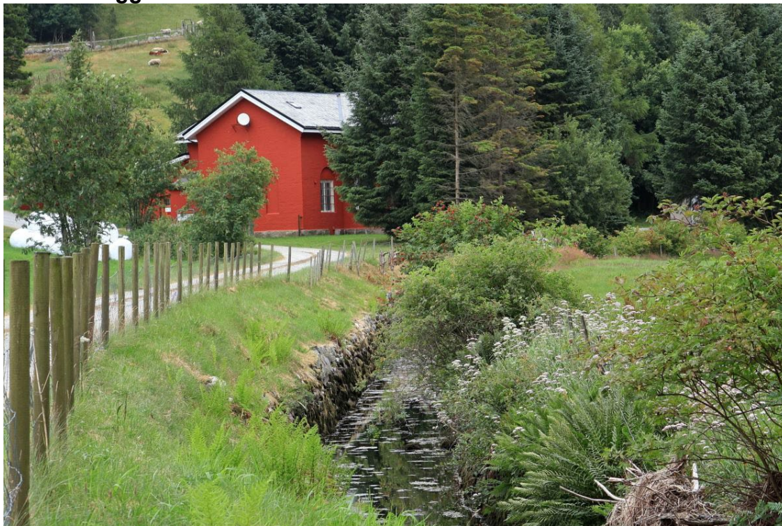
Steinsatt kanal opp mot Sviland kraftstasjon
