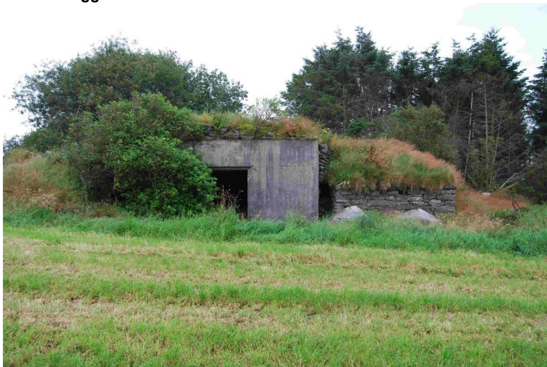
Støttepunkt Heigre - bunker ved Vippene
