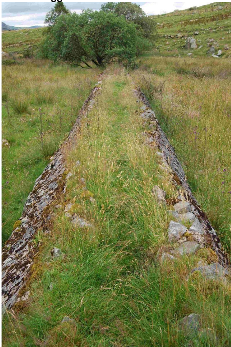
Fundament for rørledning - Grina vannverk Bilde hentet fra Sandnes kommunes kulturminneregister, 30.07.2015
