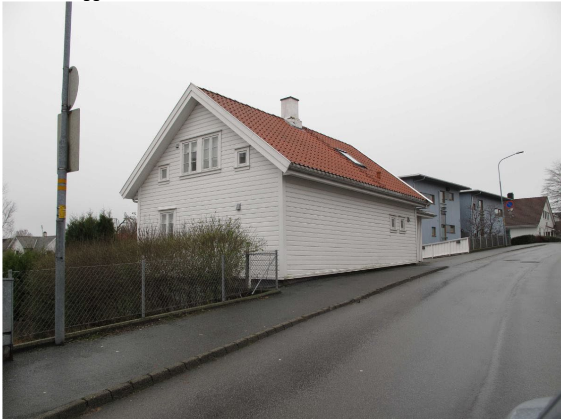
Solaveien 42 Bilde hentet fra Sandnes kommunes kulturminneregister, 27.11.2017
