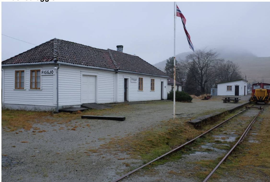
Figgjo stasjon på Ålgårdbanen. Rogaland fylkeskommune, 18.11.2020
