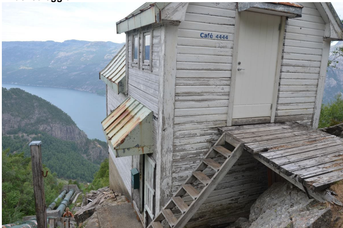
Flørlitrappene med rørgate sett fra toppen
