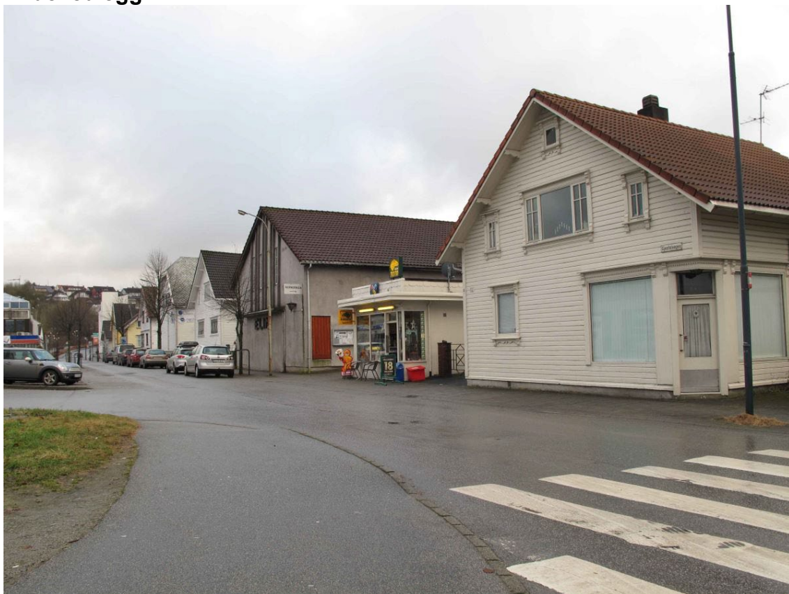
Bedehuset Elim, Bygd 1879, ombygd rundt 1970. Sandnes kommune, 04.12.2016
