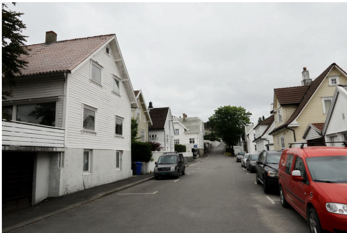
Villakvartalene bak sentrum - bygningsmiljø i Christies gate Bilde hentet fra Sandnes kommunes kulturminneregister, 13.07.2018
