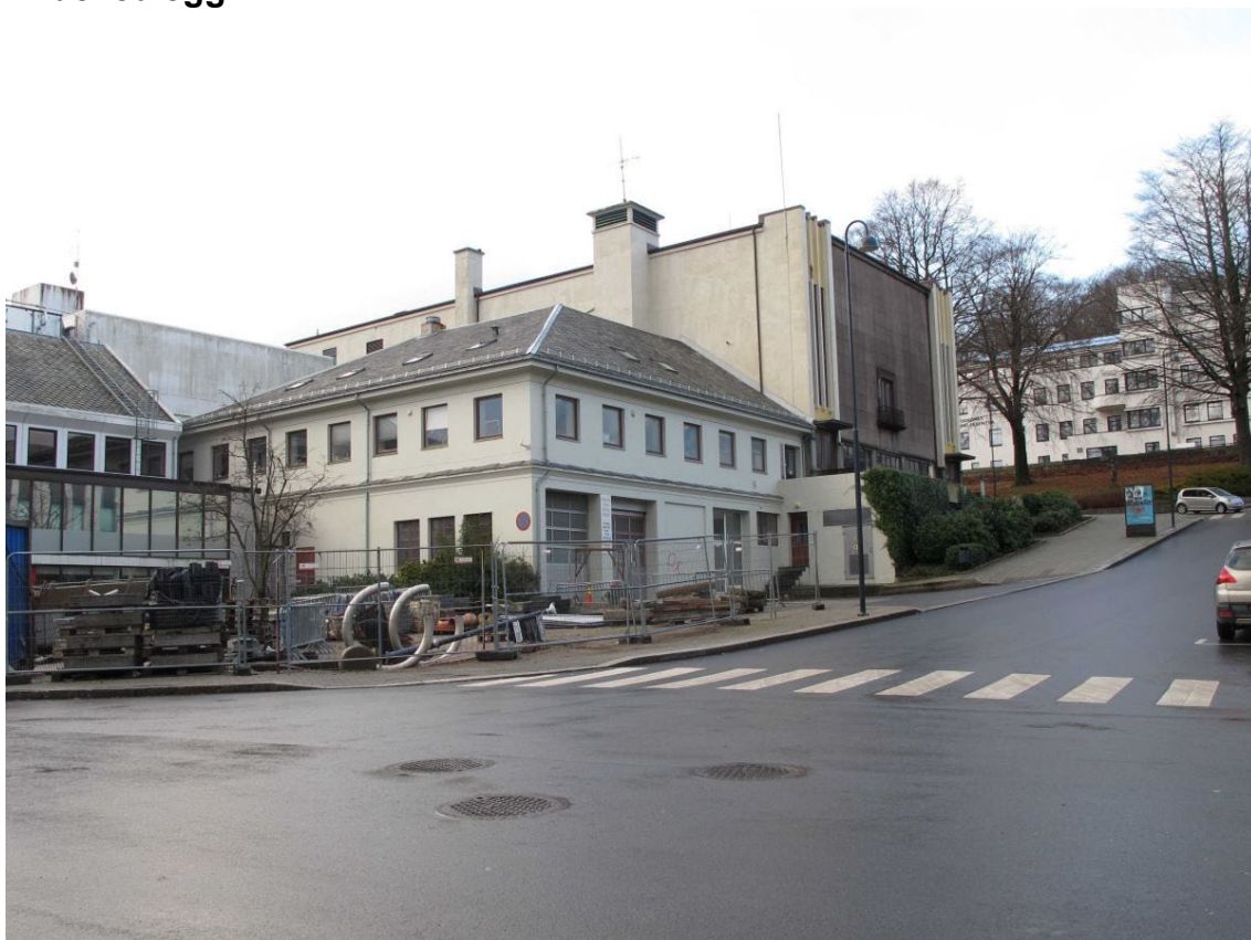
Kvartalsbyens sentrum: Bygninger ovenfor Gamlatorvet: Den gamle brannstasjonen, Rådhuseteateret og Sandnes sykehus.
