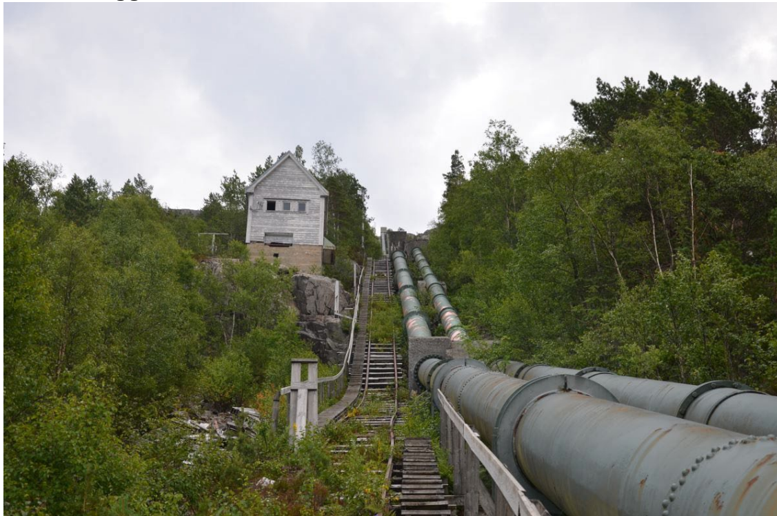
Flørli trappene med rørgaten
