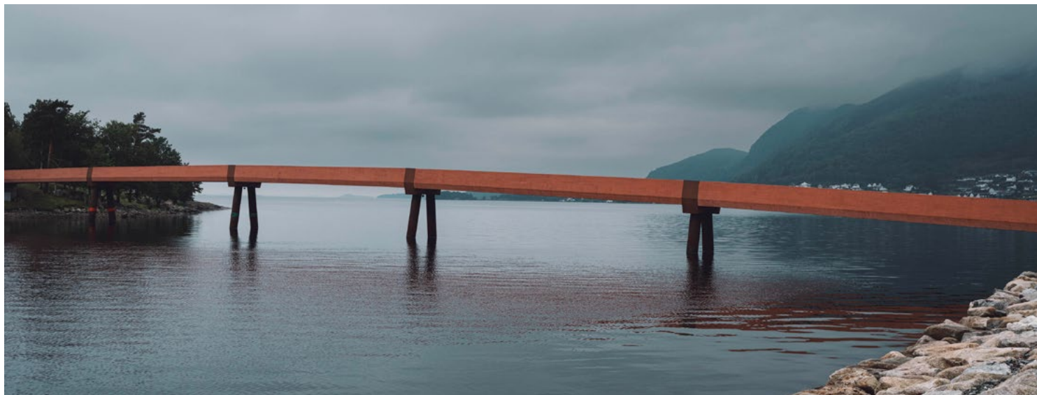
I 2017 stod gangbroen til friluftsområde Jørpelandholmen i Strand kommune ferdig. Prosjektet er spillemiddelfinansiert.
