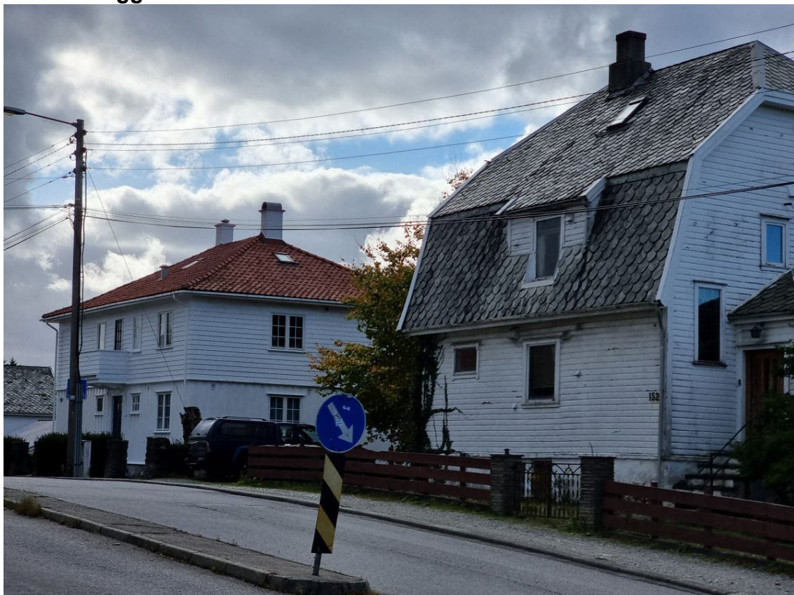
Rogalandsgata krysser Skjoldavegen og flere av husene er fra samme periode. Rogaland fylkeskommune, 15.10.2024 13:27
