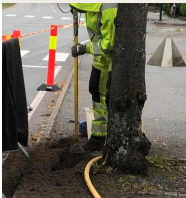
Figur 8 Luftspade brukt til prøvegraving i gate
