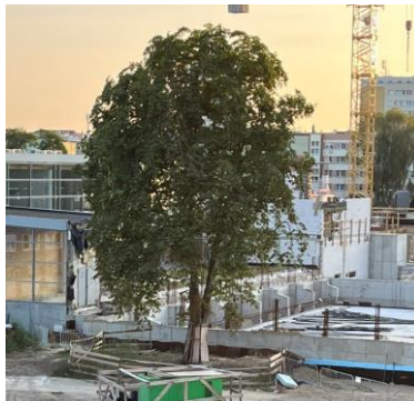
Figur 6 Enkelttre beskyttet med gjerde og stammevern
