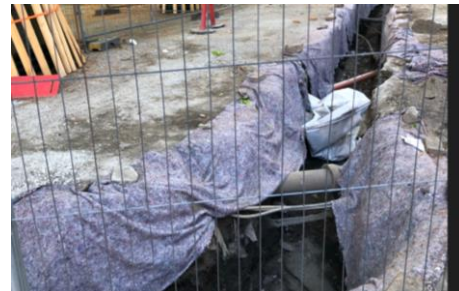
Figur 10 Røtter dekket med duk langs hele grøft.
