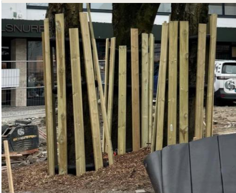
Figur 7 Stamevern som beskytter trær når arbeid er utført i nærheten.
