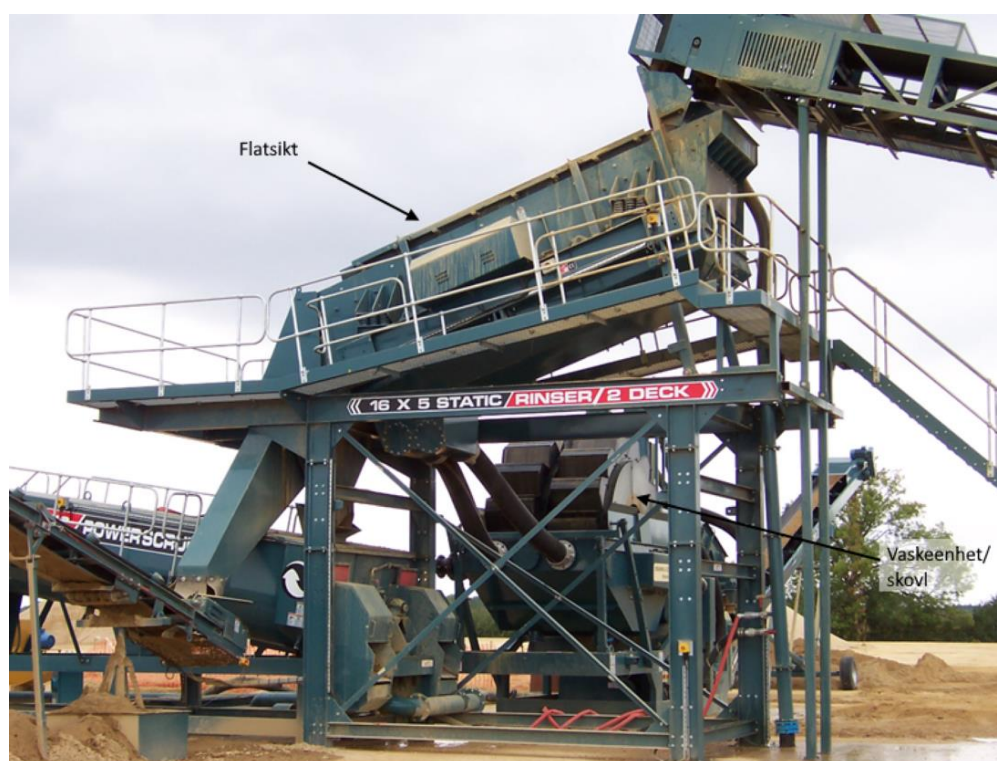
Figur 3: Spyleanlegg i flatsikt.
