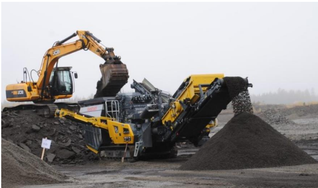
Figur 8: Bilde av asfaltknusing (kilde: fredheim-maskin.no)
