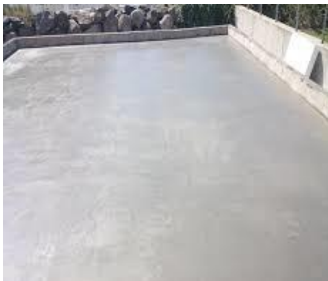
Figur 14: Tett betongdekke for å samle opp forurenset vann. På det lille bildet vises et tverrsnitt av en sedimentasjonskum (kilde: nobi.no).
