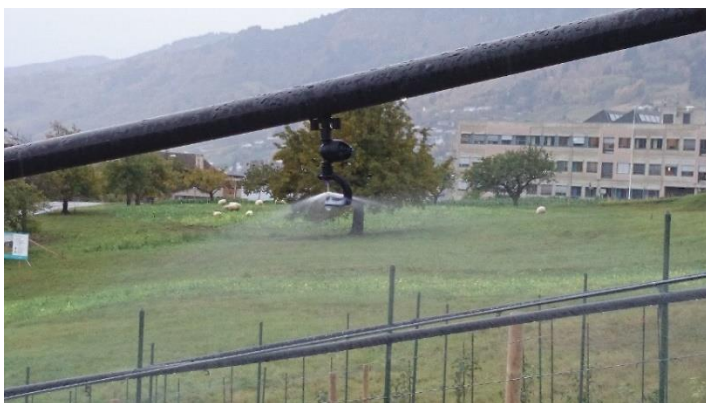
Figur 12: Overrislingsanlegg. Vanntåkesystem er vist på bilde til venstre og en enklere utgave laget av dreneringslange til høyre.
