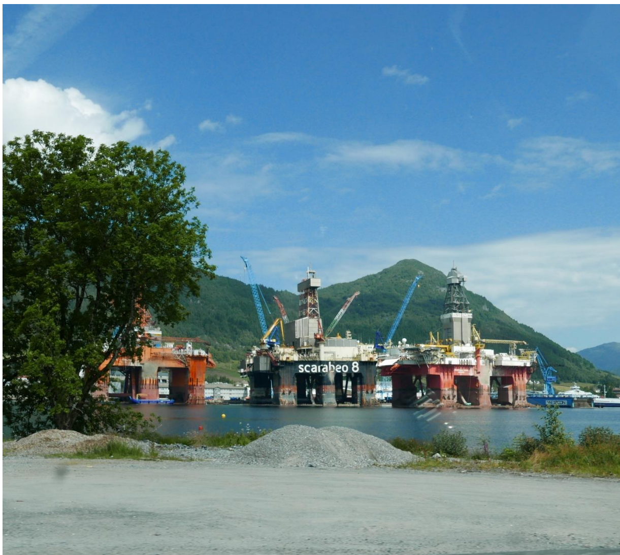
Tre plattformer hos Westcon Yards i Ølensvåg, Vindafjord kommune. Foto: Odd Helge Løyning
