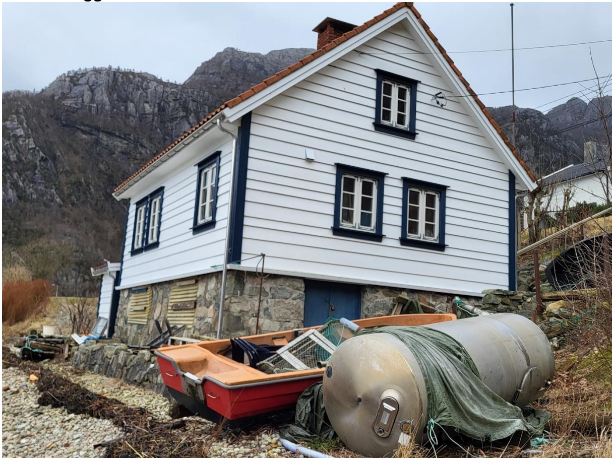
Bolighus nord langs Dirdalsstranda.
