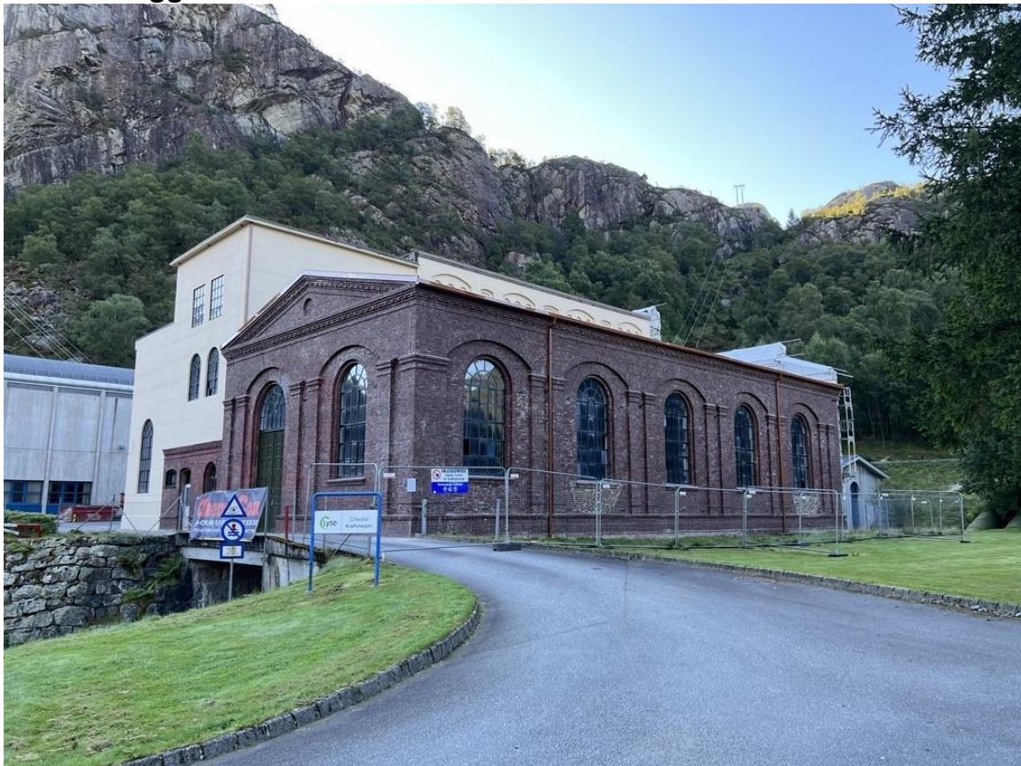
Kraftstasjonen fra 1909, i bakkant skimtes det ny kraftverket fra 1994.
