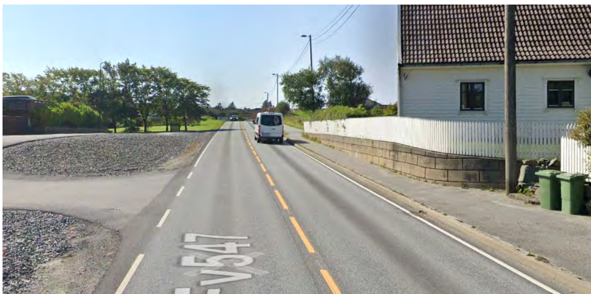
Figur 2-20: Eksisterende fortau er stedvis svært smale
