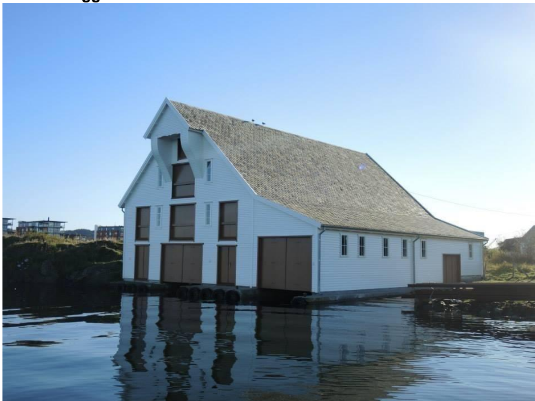
Nylandhuset i Løvågen ferdig restaurert. Foto: Haugesund kommune
