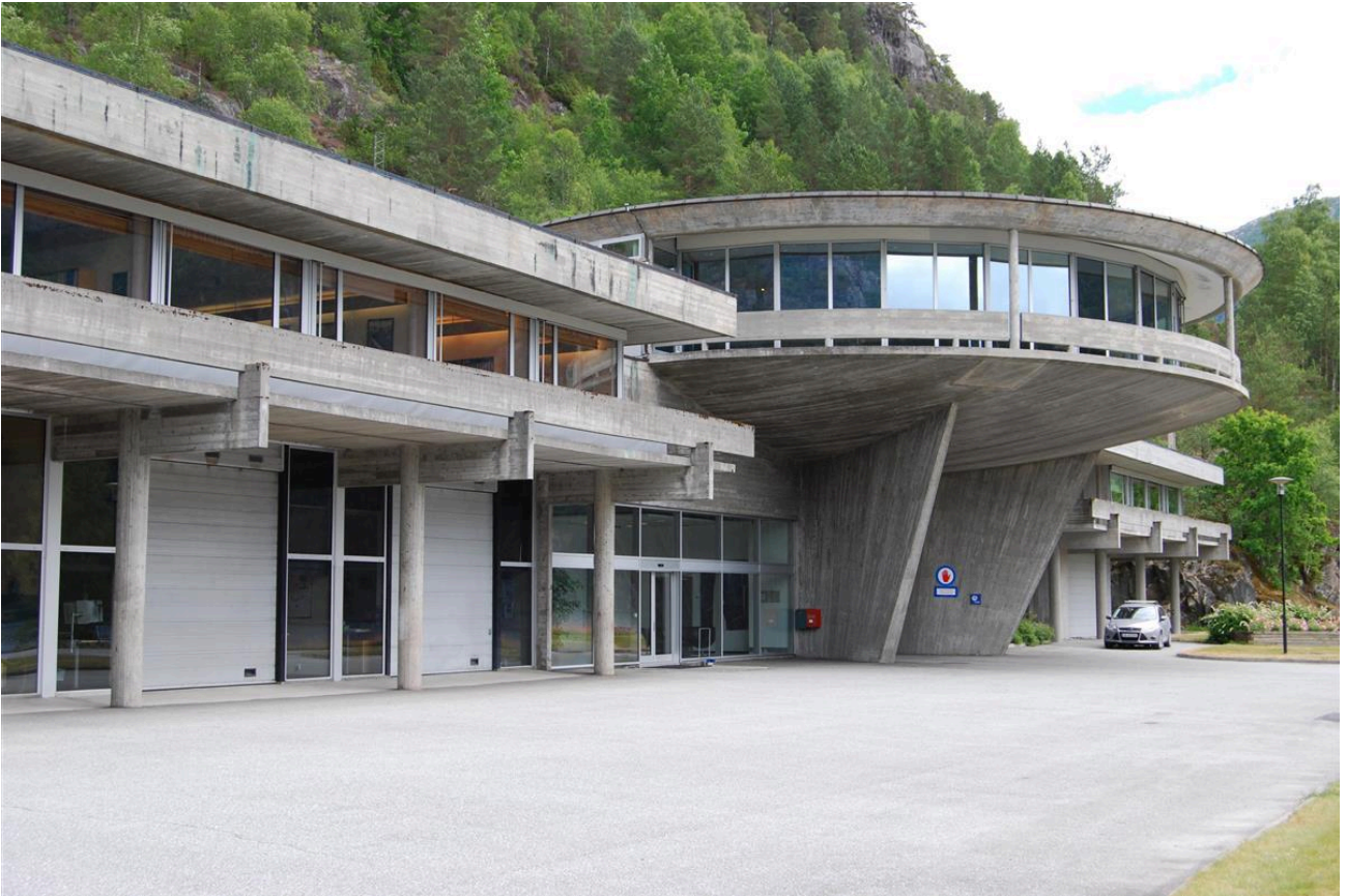
Suldal kraftstasjon på Kilen, Nesflaten i Suldal, er teikna av arkitekt Geir Grung. Foto: Rogaland fylkeskommune
