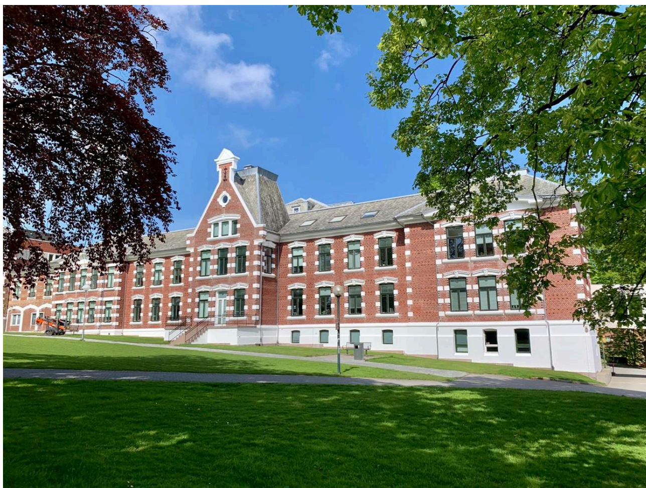
Gamle Stavanger sykehus blei bygd i 1897, og er teikna av Arkitekt Hartvig Eckhoff, som og teikna Rogaland teater og Stavanger museum. I 1984 overtok Rogaland fylkeskommune bygga. Foto: Rogaland fylkeskommune
