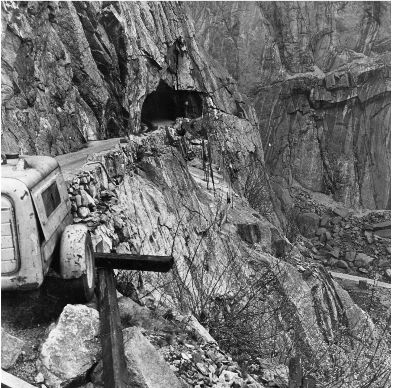
Vegarbeid på Riksvei 44 over Jøssingfjord i 1970.
