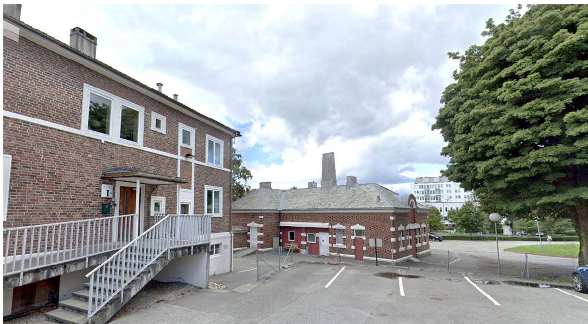
Figur 39 Bygg I til venstre og bygg J sentralt i bildet.
