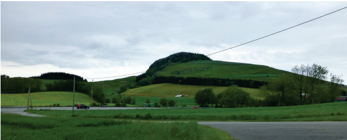
Figur 2-11. Fra kryssområdet ved E39 på Bråstein og frem mot tunnelpåslag under Bråsteinåsen.
