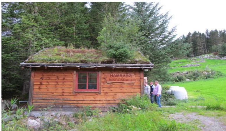
Hamrabø mikrokraftverk-Suldal Foto: Kjell-Ove Hauge
