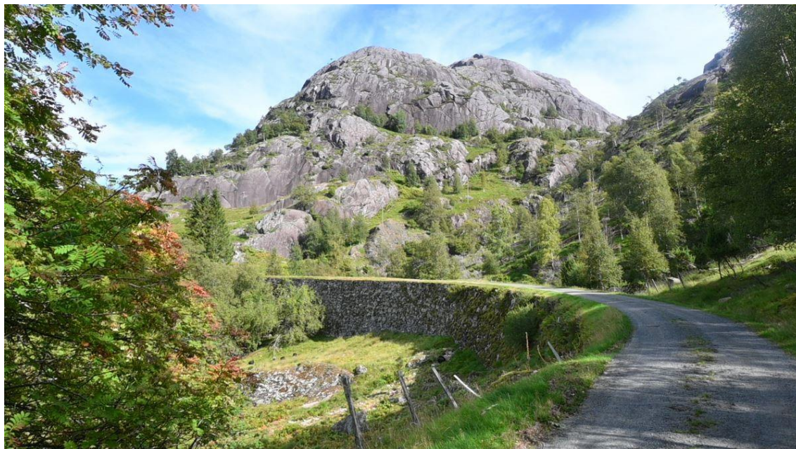
Anleggsvei ved Blåfjell
