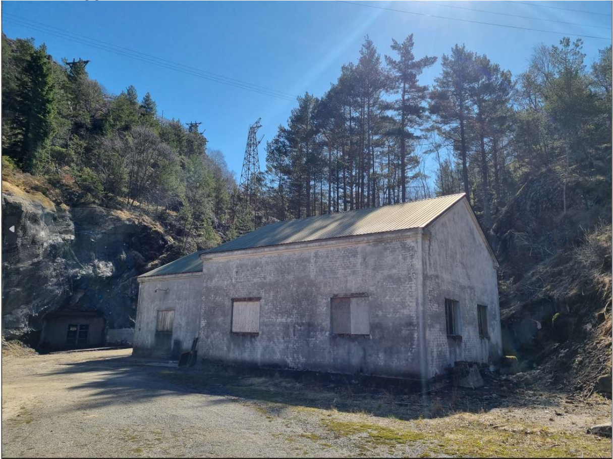
Gruveinngang til venstre i bildet.
