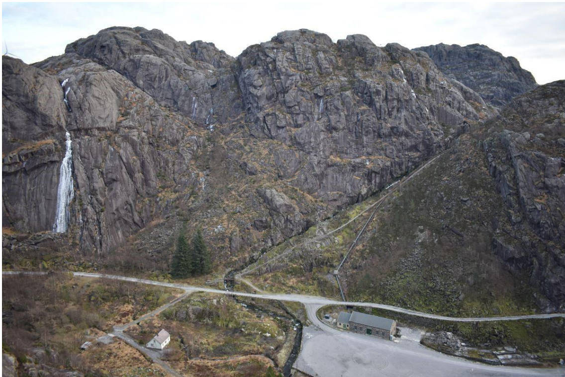
Utsikt mot trallebane og kraftverk.
