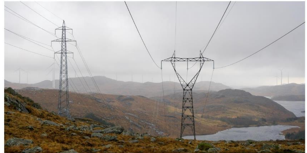
Kraftledninger og vindmøller sett fra Brusaknuten mellom Hå og Bjerkreim kommune.
