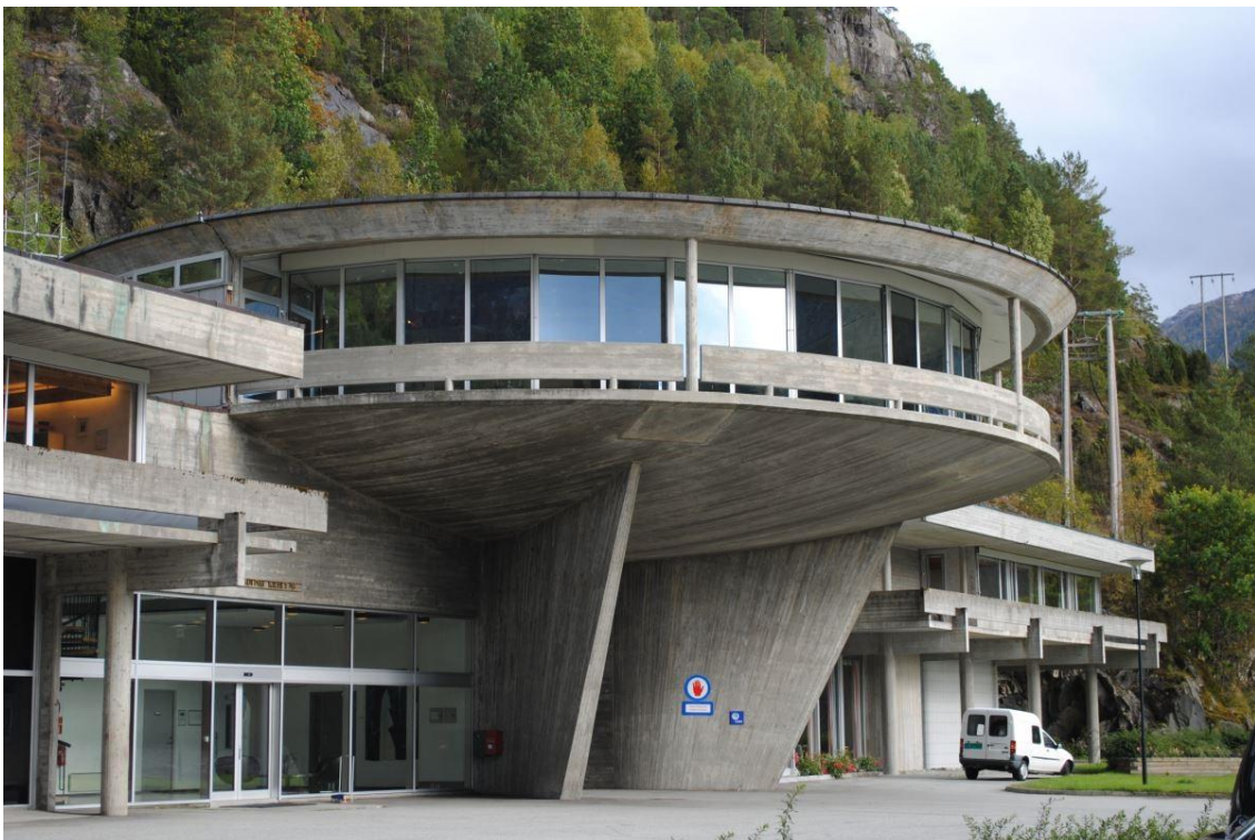
Detalj frå kraftstasjonen på Kilen
